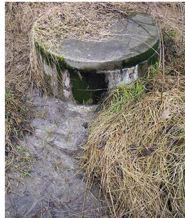
Et avløpsanlegg som ikke fungerer kan se slik ut.
