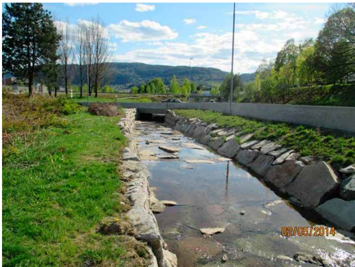
Figur 7.6. Setrebekken i Notodden (kulvert under FV 360 ved krysset med E134), som var en bekk i løsmasser som nå er sikret mot erosjon. På bildet ses det også en betongmur langs E134, for å sikre veien mot nye flomskader. Foto: Gunnar Mosevoll
