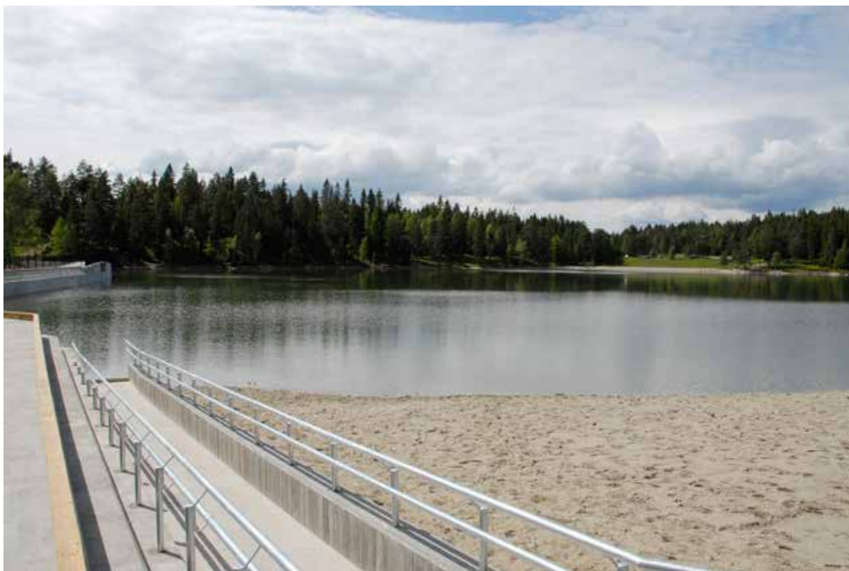
Figur 7.4. Tidligere vannverksdam i Drammen som er sikret og tilrettelagt for annen bruk. Foto: Birgitte Simensen Berg
